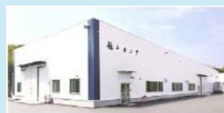
倒壊した工場・施設等の復旧支援
