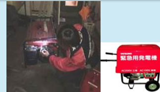
・自家発電機の導入
