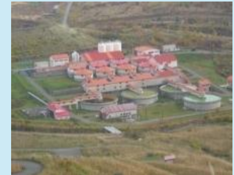
（坑廃水処理施設の例）
