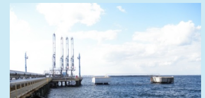
※ 製品出荷棧橋の土台
